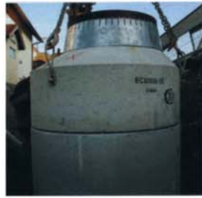
Schnelle mörtelfreie Verbauung mittels Stecksystem.
