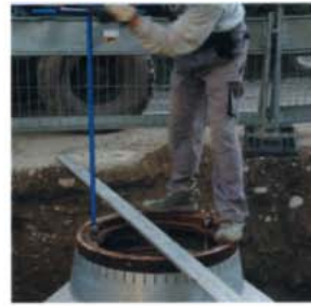
Kontrolle und Einstellen der Schachthöhe.
