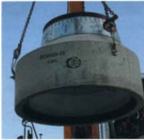
Aufsetzen des Schachtkonus. Bilder: econorm
