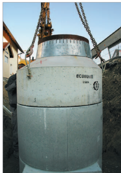
Aufgesetzter Schachtkonus. Schnelle mörtelfreie Verbauung mit dem Stecksystem
